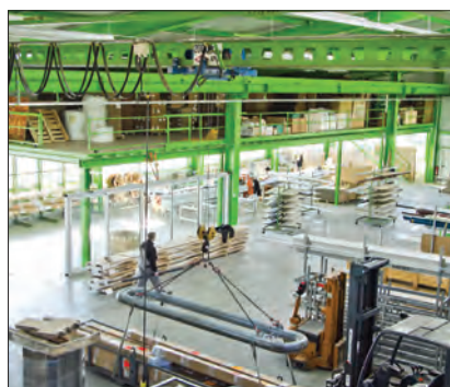
Teilansicht Lagerhalle Neubau
